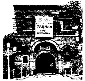
المدخل الرئيسي للسوق
